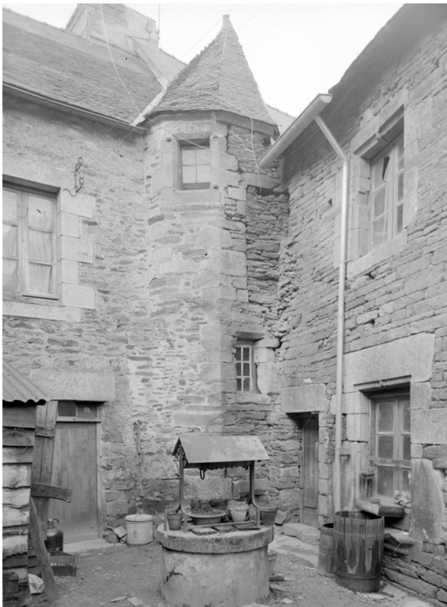
Maison B et C, tourelle d'escalier dans l'angle nord-ouest de la cour intérieure.
