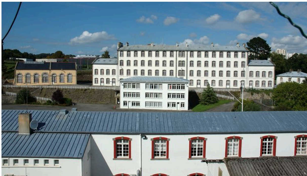
Vue de situation depuis la Cavale Blanche (état en 2005)
