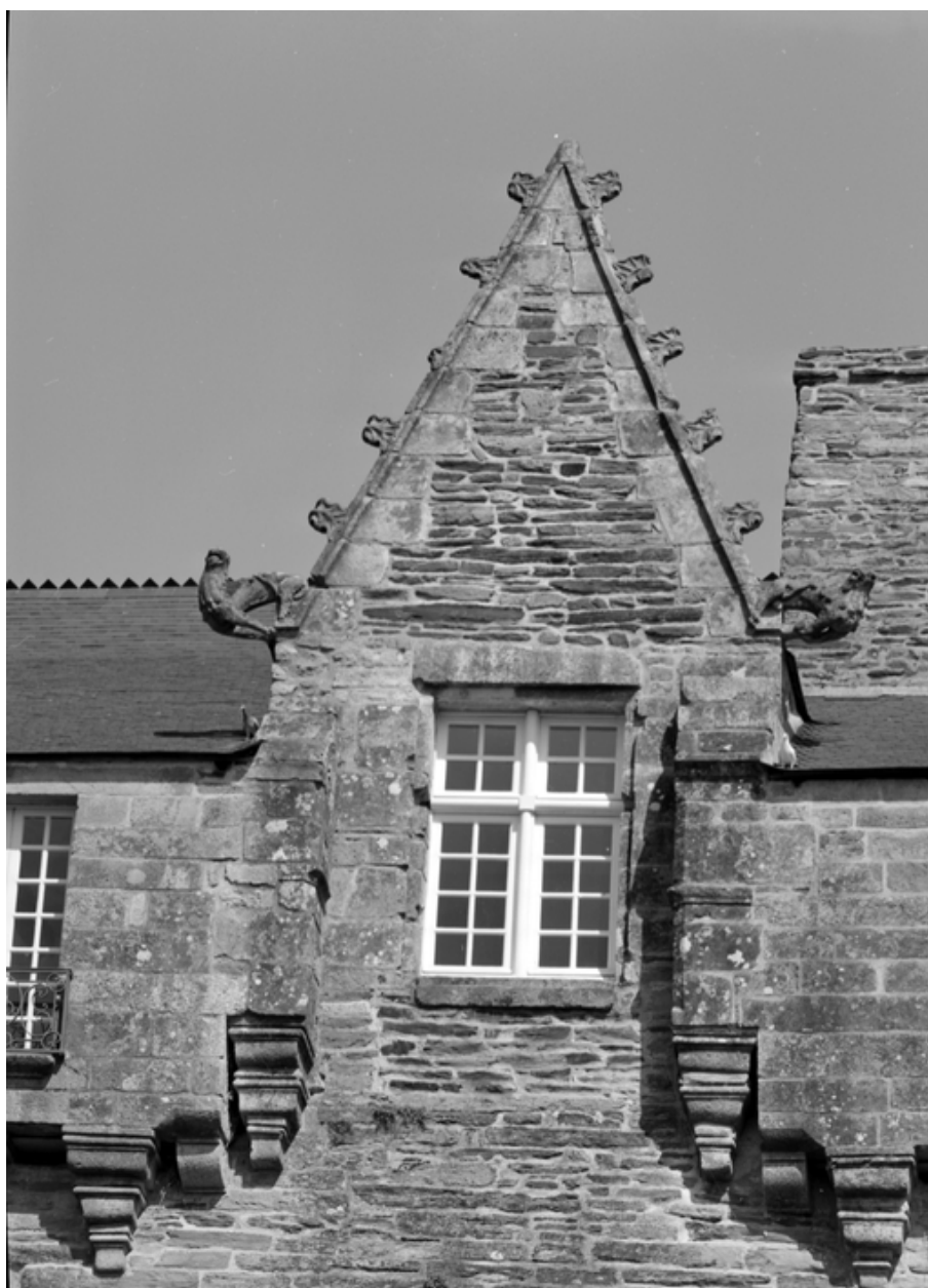
Aile ouest, deuxième lucarne à partir du nord.
