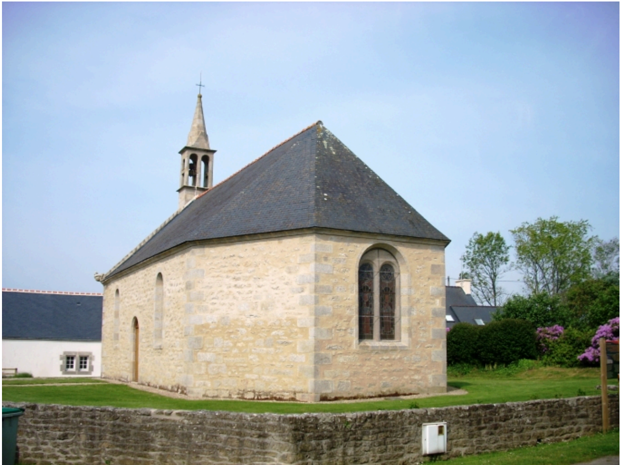
Plomeur, chapelle Saint-Côme et Saint-Damien : vue générale sud-est
