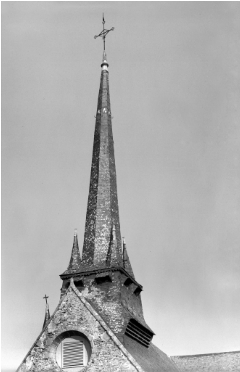
Elévation Est, clocher : vue générale
