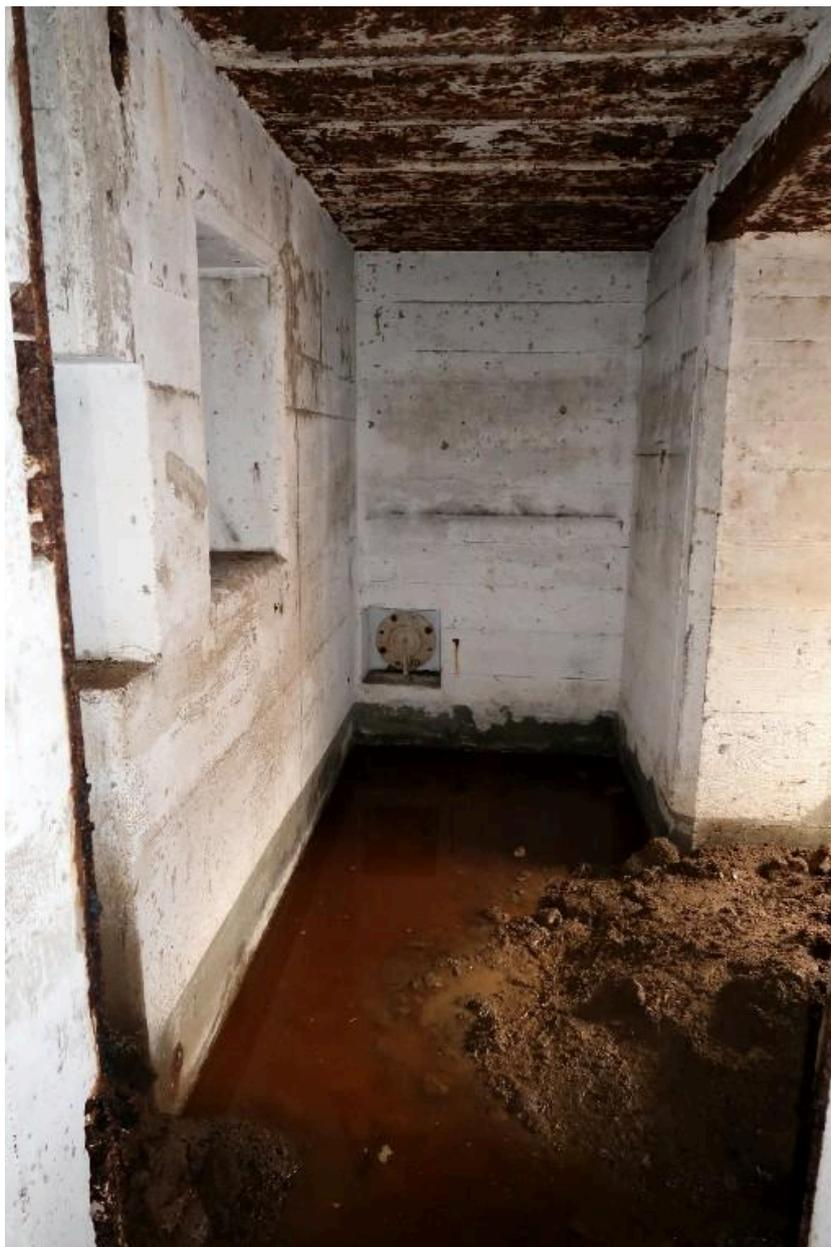
Vue de l'entrée nord : extrémité nord du couloir avec une bouche de surpression à clapet à contreponds en aluminium. A gauche, emplacement d'un passage d'antenne et du créneau de tir défendant l'entrée
