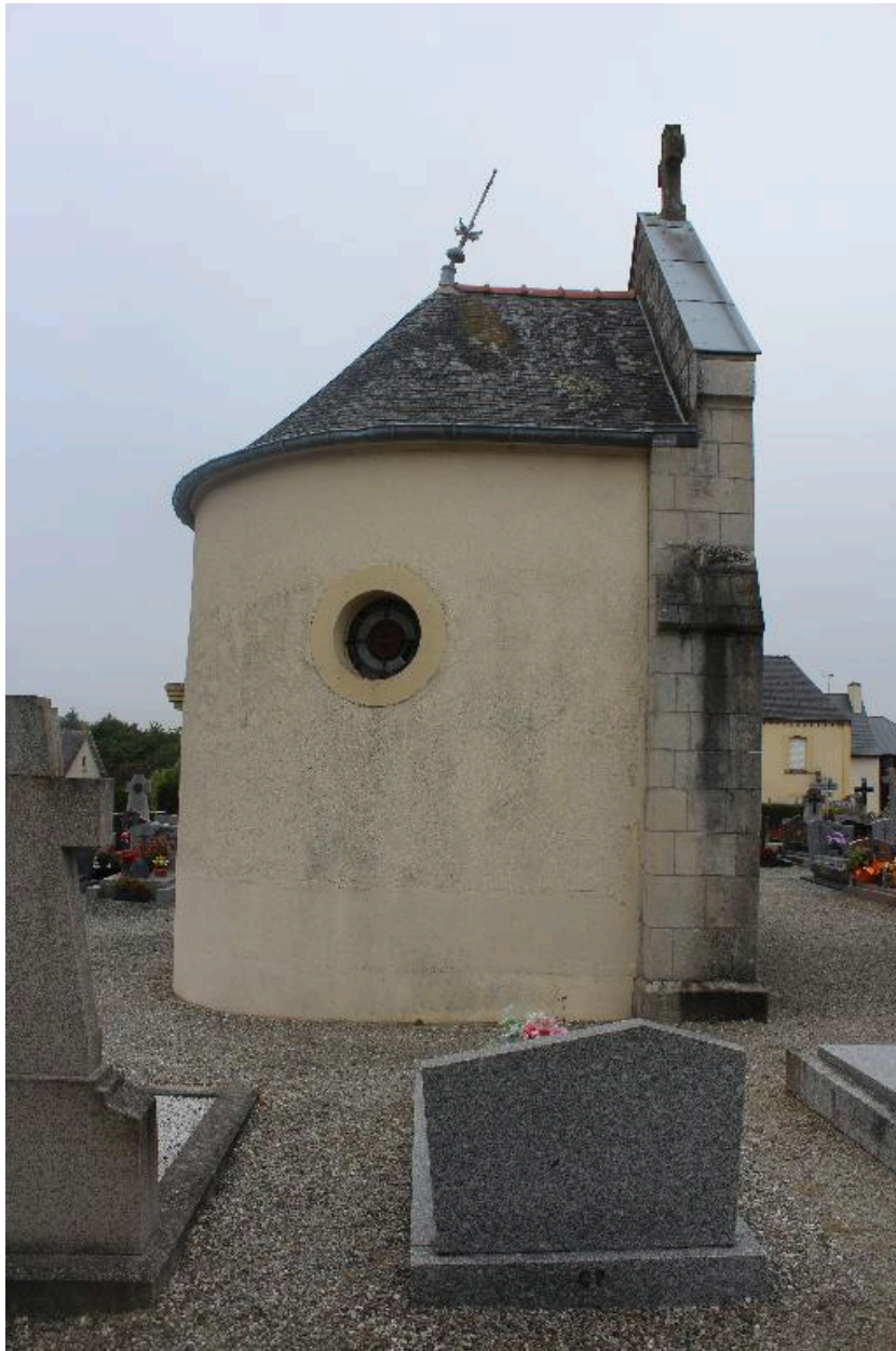
Côté est : vue générale
