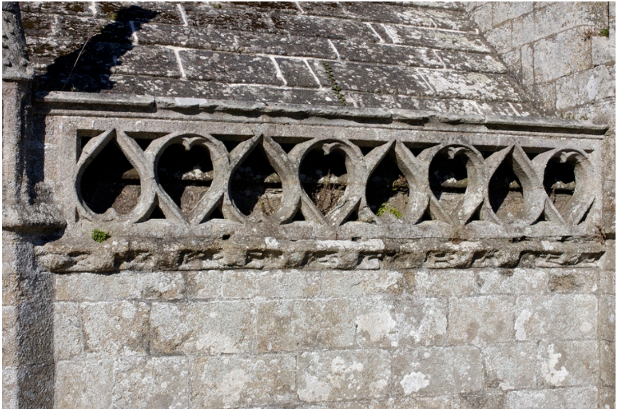
Sacristie-chambre du trésor, détail de la balustrade
