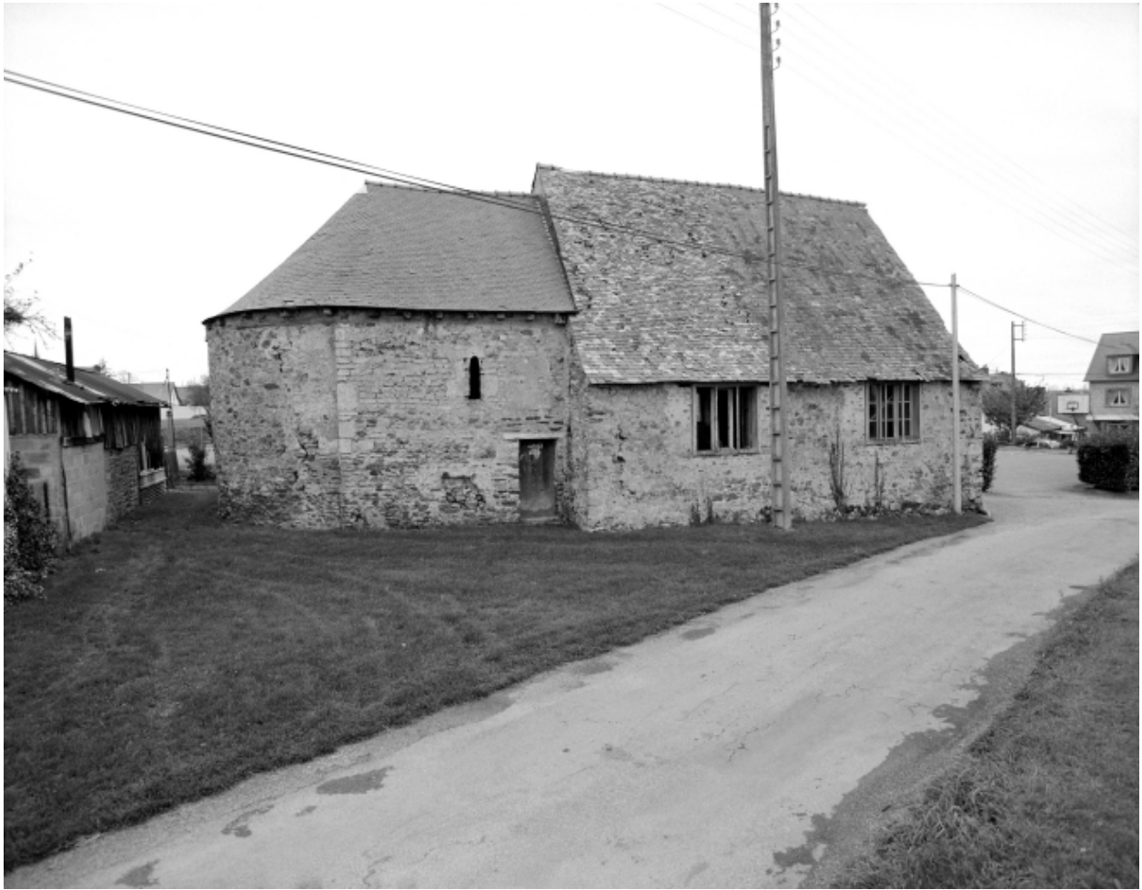
Vue générale nord ; état en 1992
