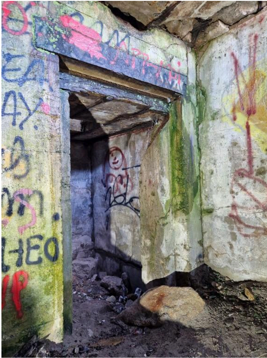
Vue intérieure : entrée de la petite pièce servant d'observatoire avec puits de périscope
