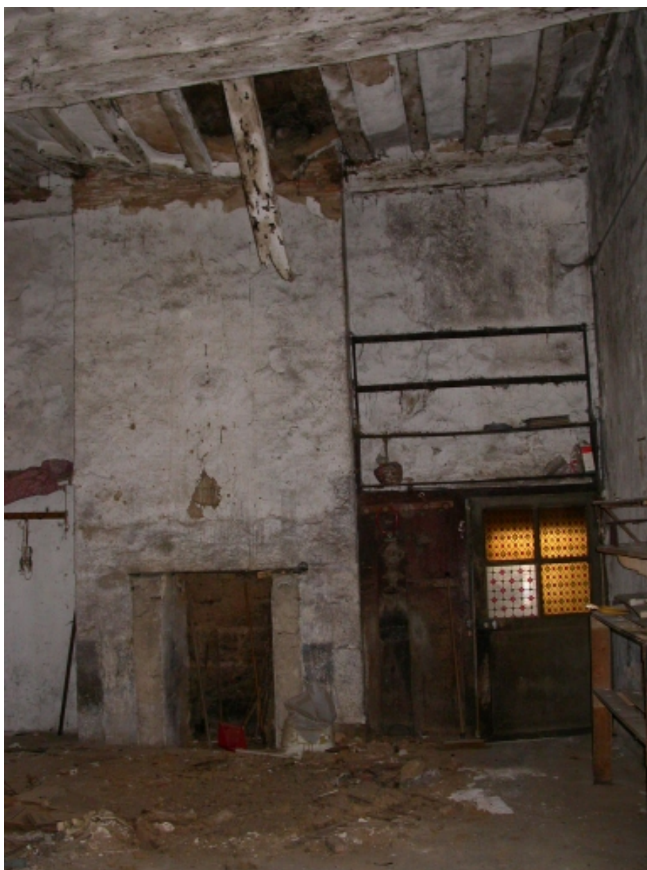
Salle située à l'arrière du bâtiment
