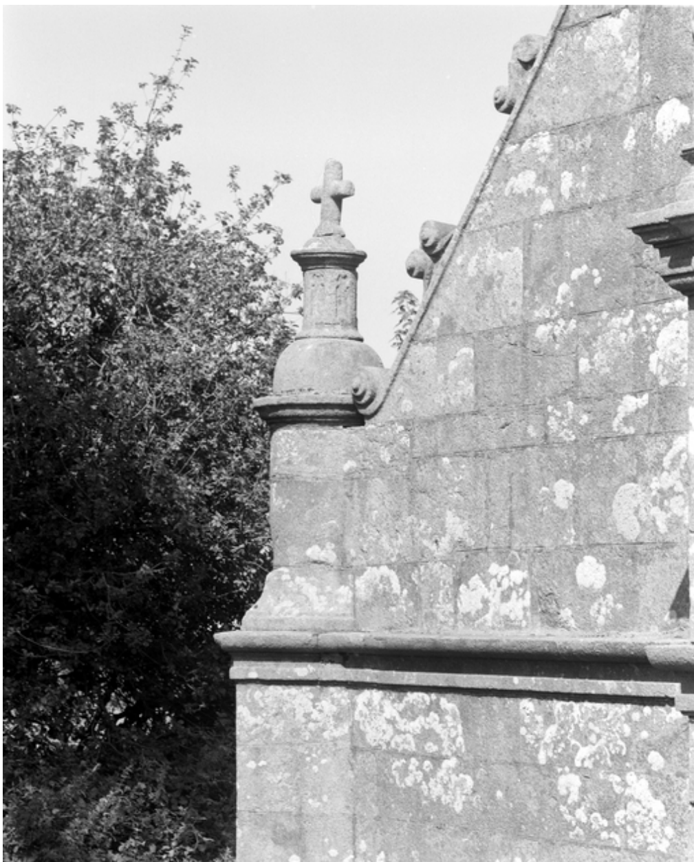
Détail du rampant nord de la face ouest
