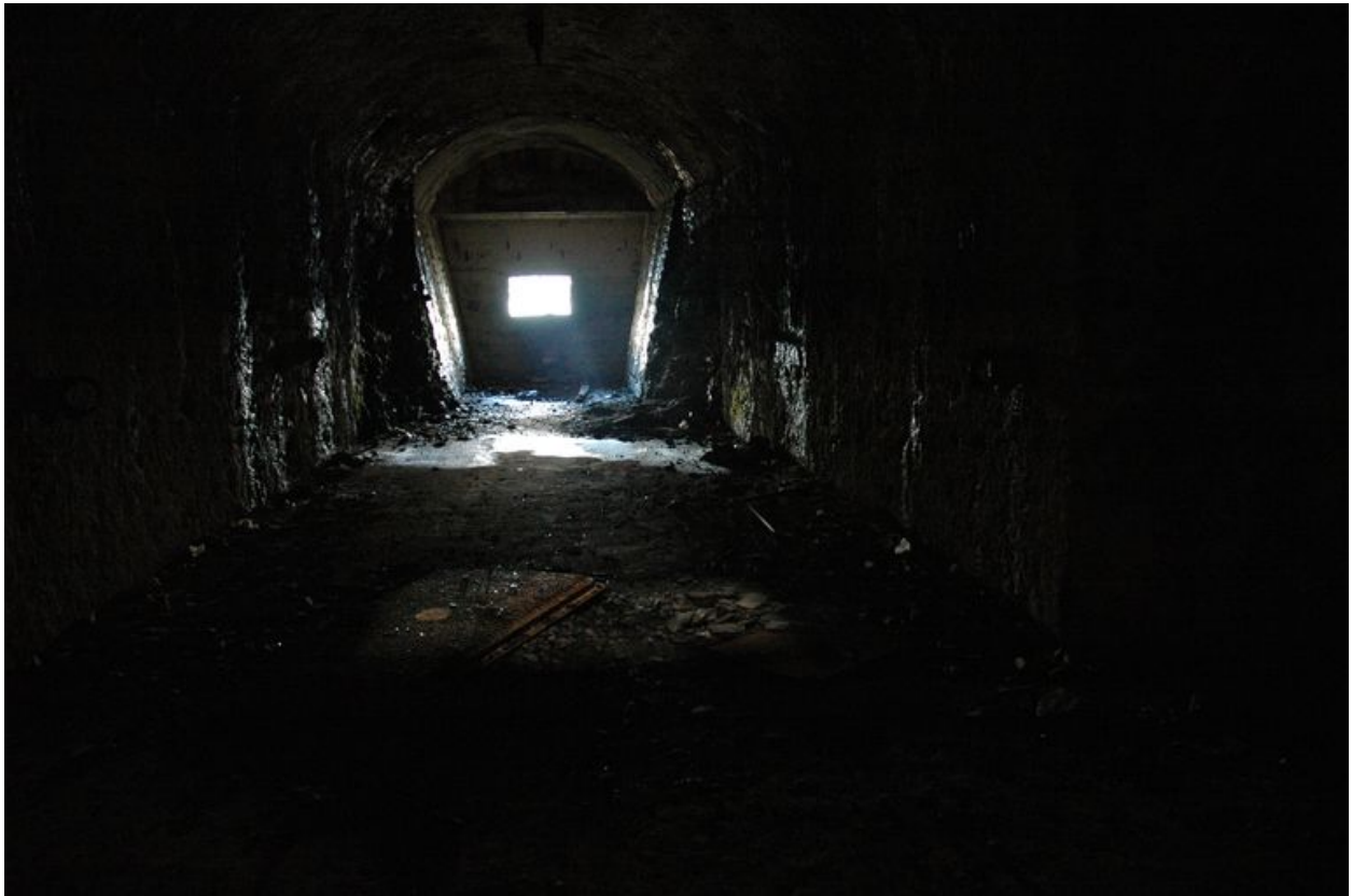
Vue de l'une des deux chambres de tir augmentée d'une casemate en béton armé (état en 2006)
