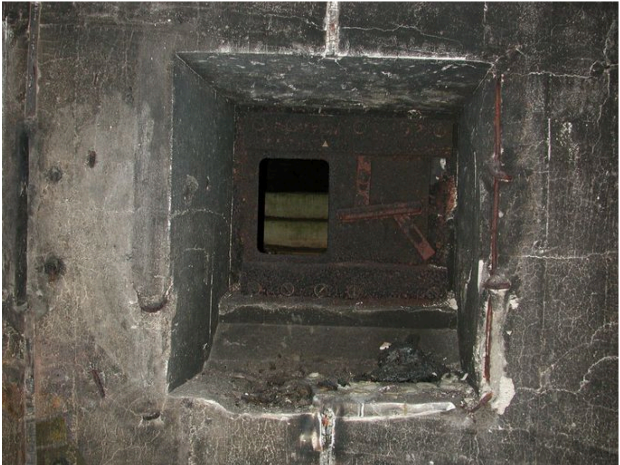
Vue du couloir d'accès : détail du créneau de tir blindé (état en 2002)
