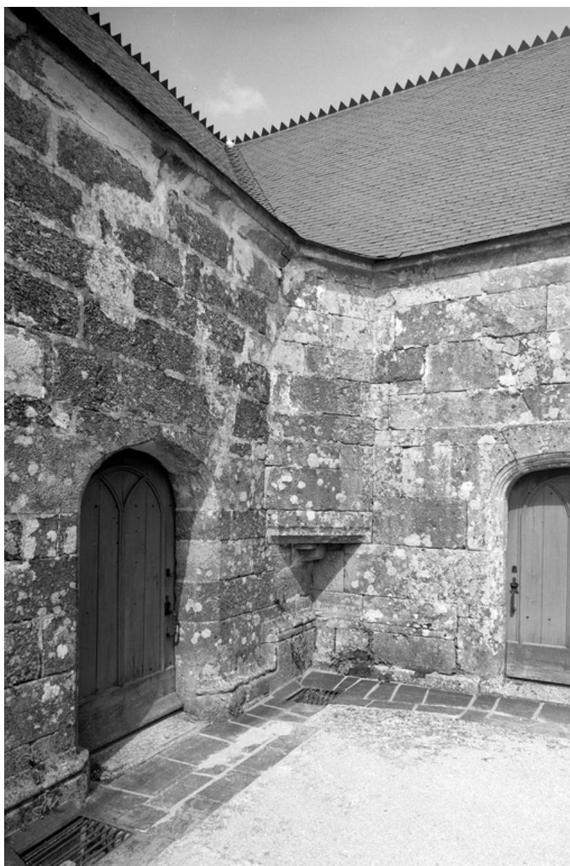
Façade sud : détail de l'angle nord ouest du croisillon sud
