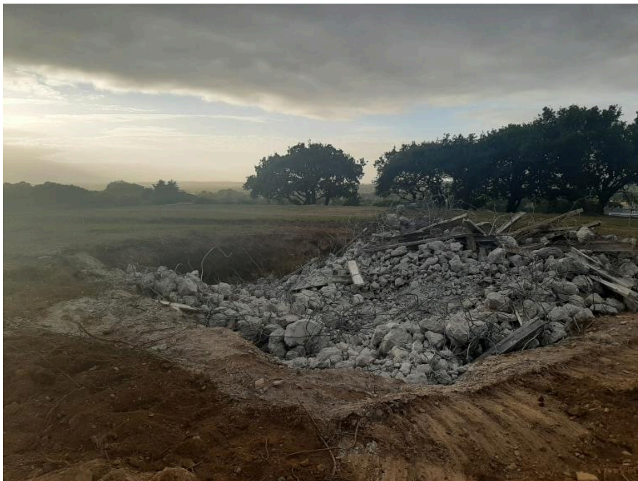
Vue de la déconstruction (26 septembre 2022)
