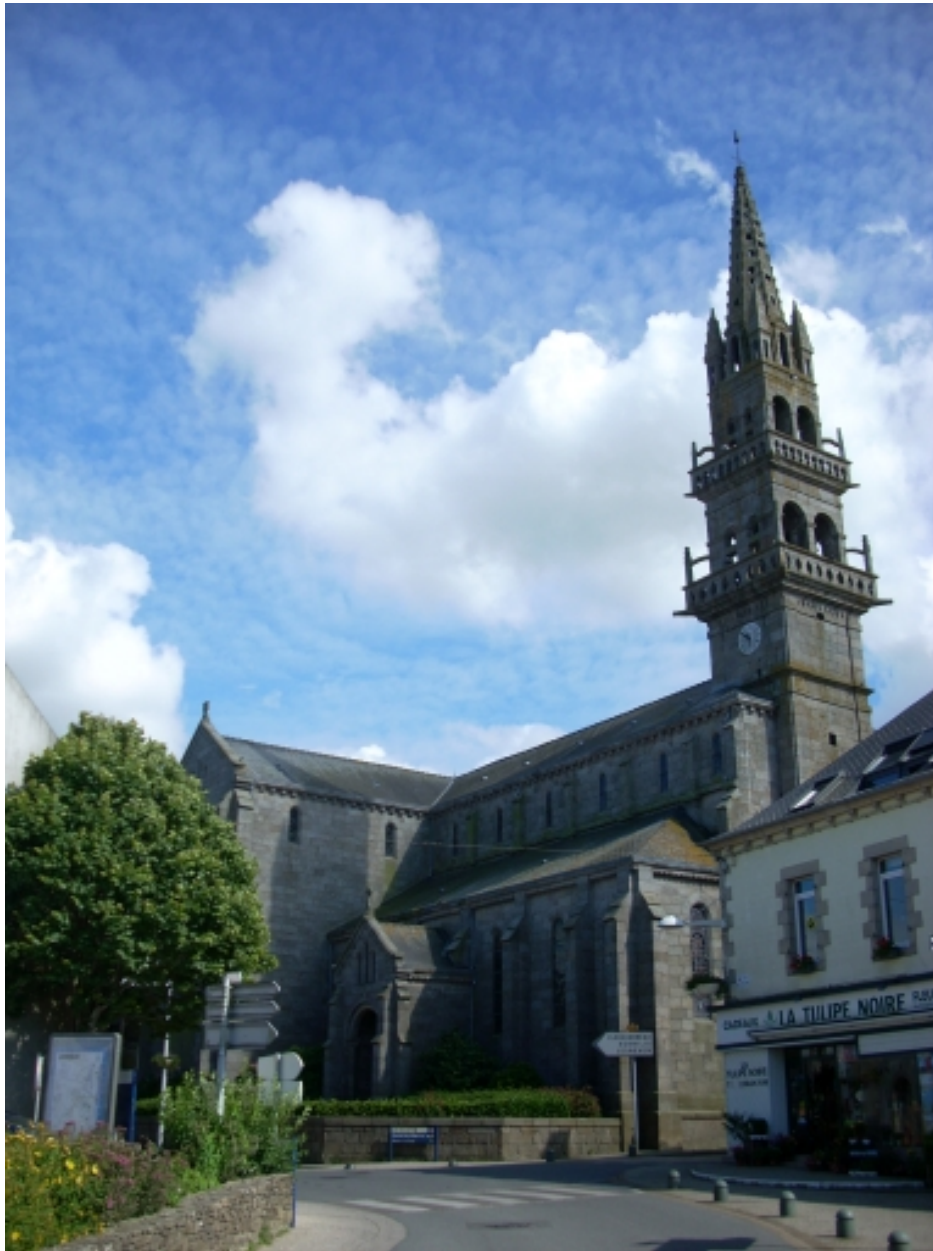
Lannilis, église paroissiale : vue générale nord-ouest
