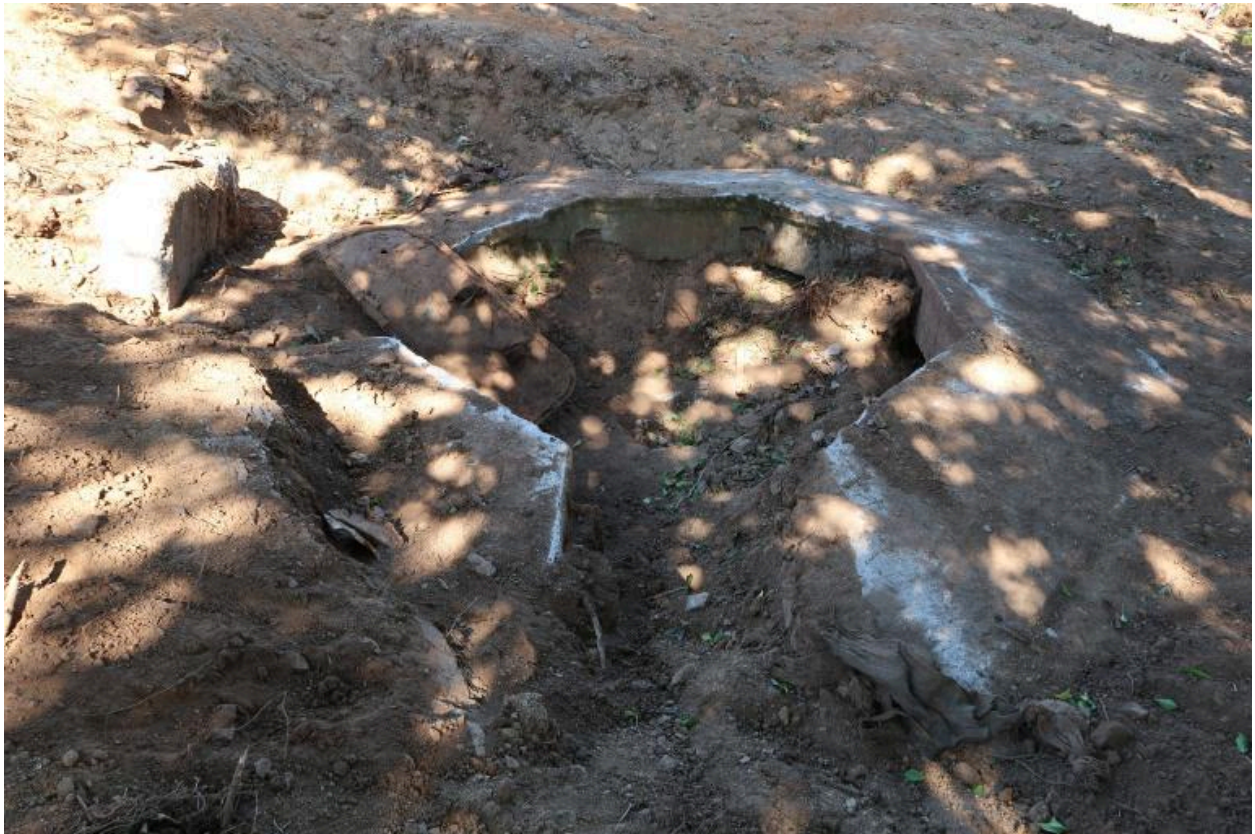
Vue générale (août 2022, chantier en cours)
