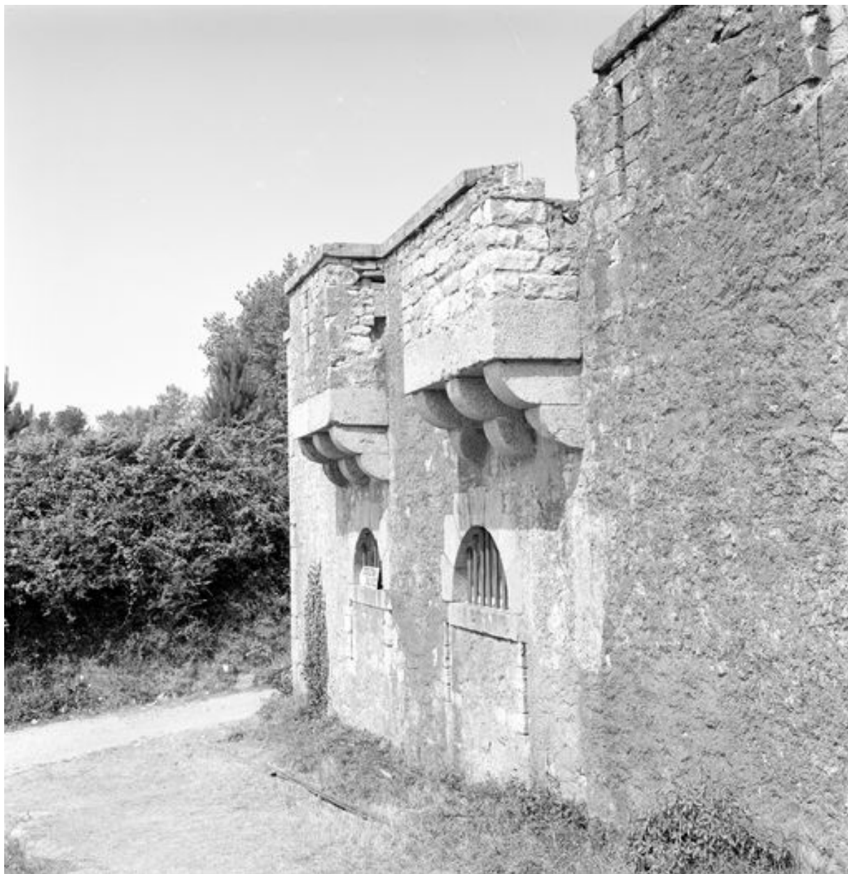
Vue du corps de garde crénelé n° 3 du bourg de Roscanvel en 1969 : façade sud (du côté de la cale)
