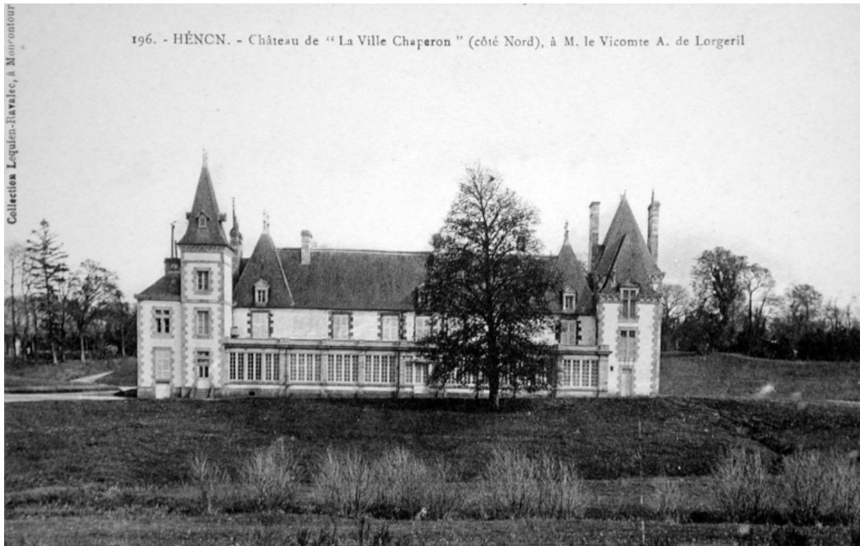
Vue générale nord
