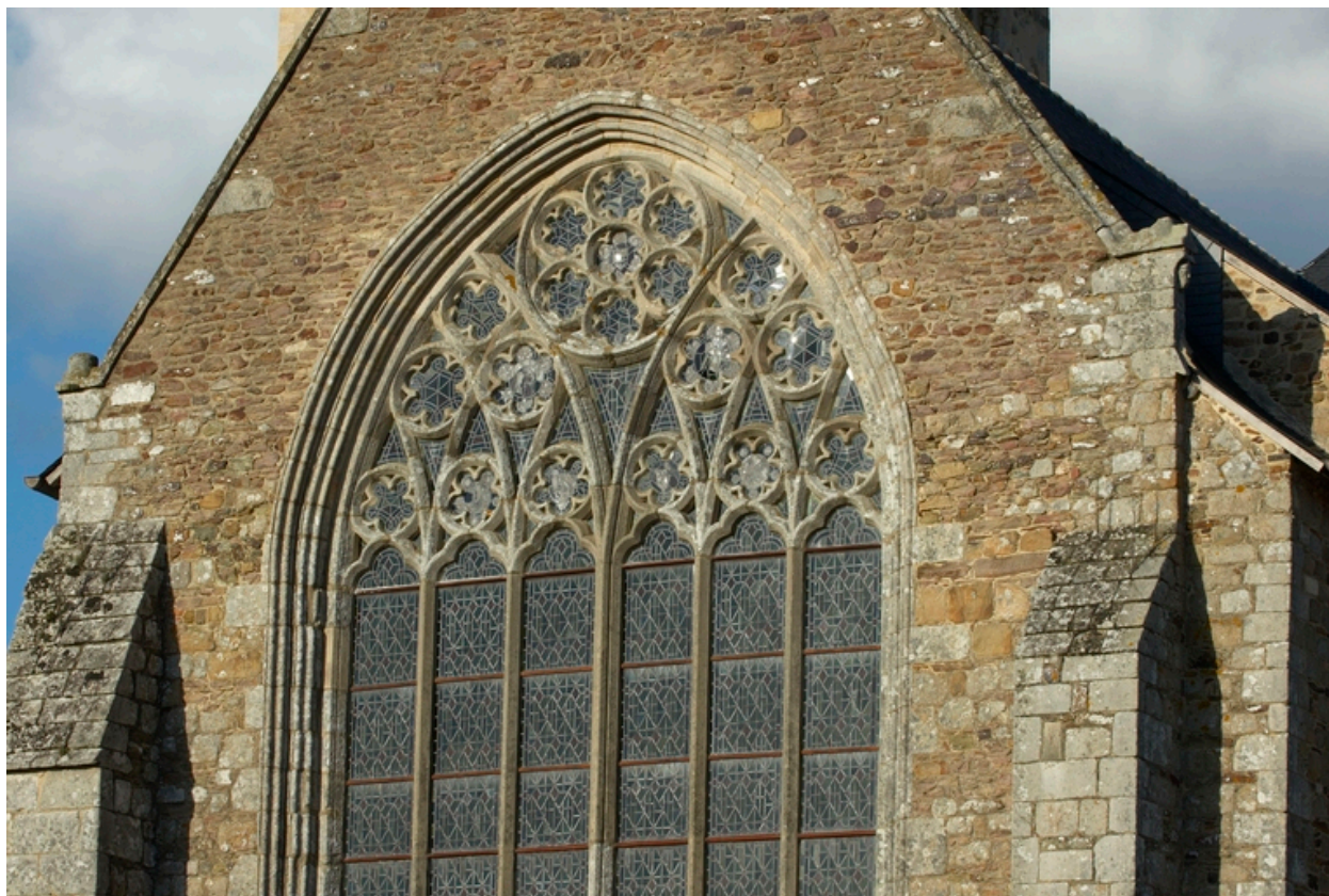
Vue de détail de la baie du transept sud
