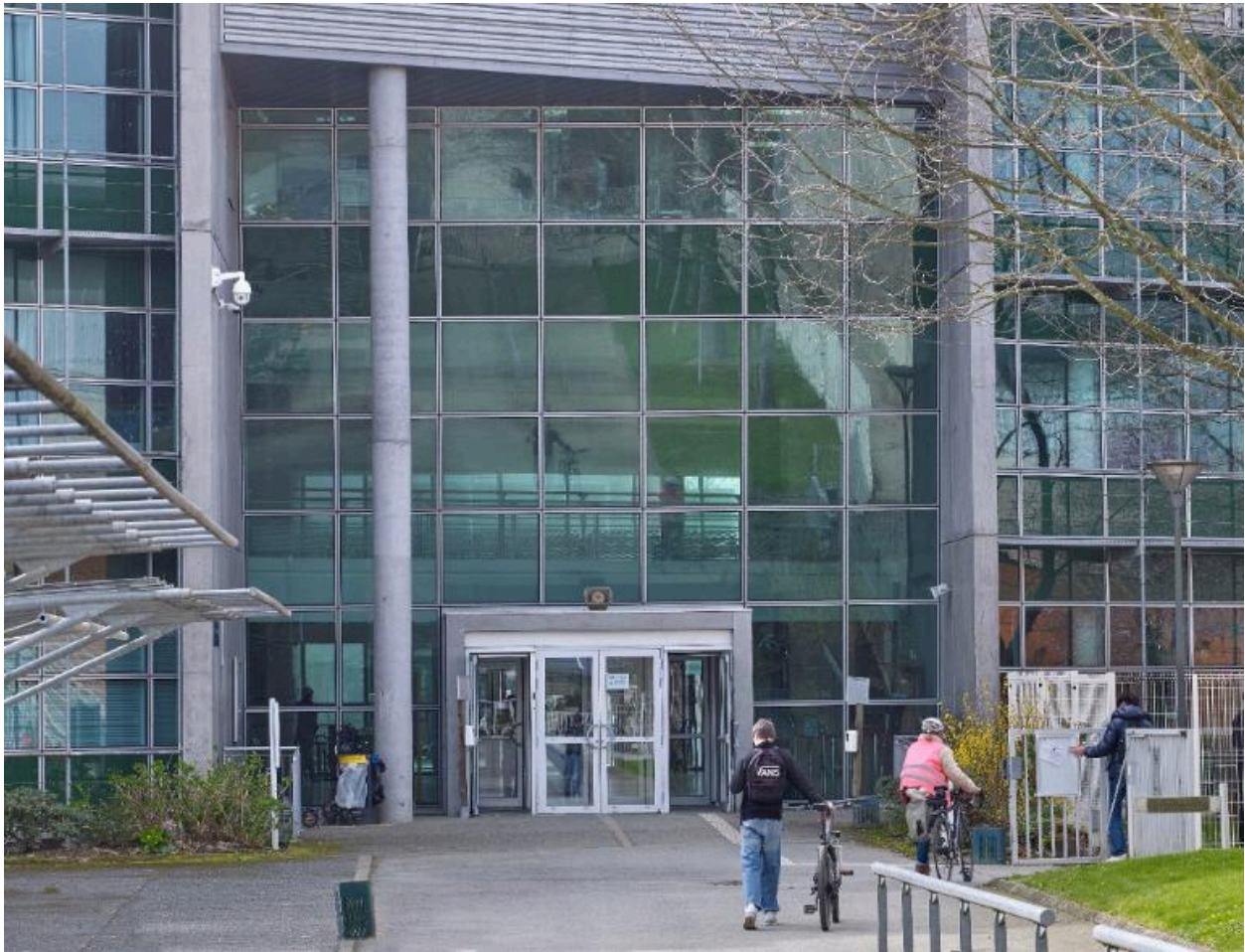
Entrée nord du bâtiment principal. Joël Y. Gautier, architecte, 1992.
