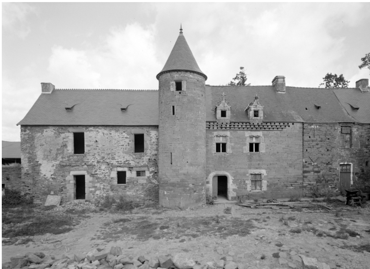
Vue de la façade sud-est
