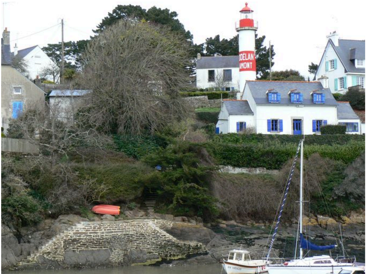
Vue d'ensemble du feu amont et de son appontement
