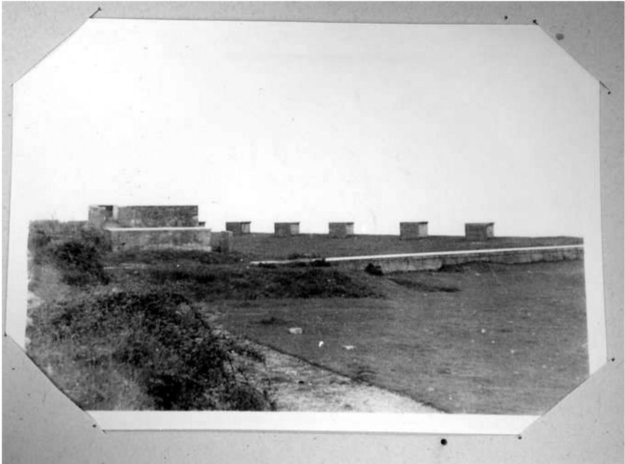
Vue de l'une des quatre cuves pour canon antiaérien de 4 cm, vers 1946 (photographie extraite du rapport Pinczon du Sel). On aperçoit également le mur défensif barrant la Palud et de nombreuses niches à munition
