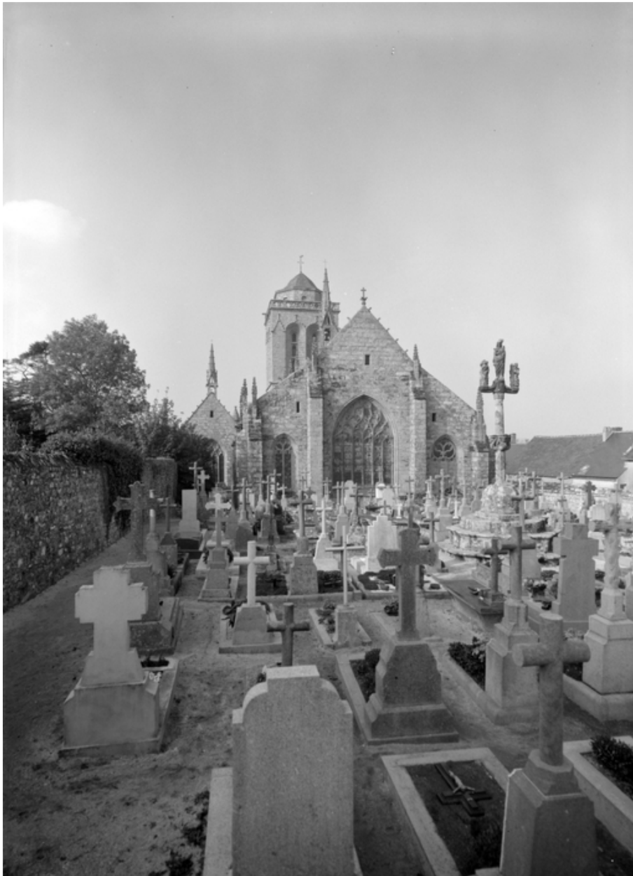
Façade est, vue générale
