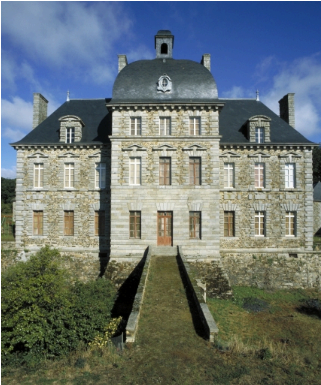
Vue générale sud
