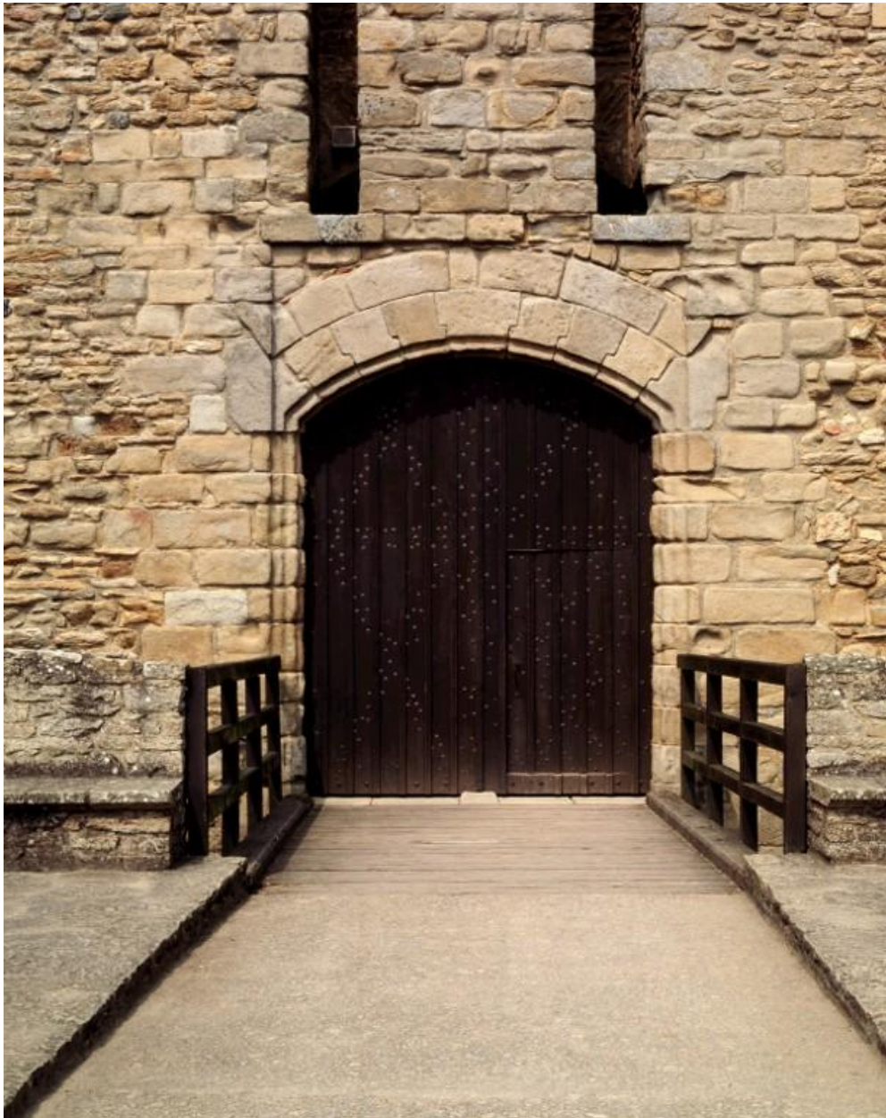
Château fort, logis est, élévation est, détail de la porte.
