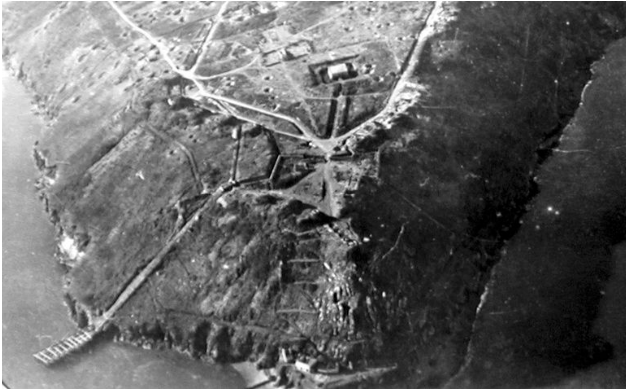
Vue aérienne (détail) de l'ensemble fortifié de la pointe des Espagnols, n° 131, rapport Pinczon du Sel. Livre IV, vers 1947, Service Historique de la Marine, Brest
