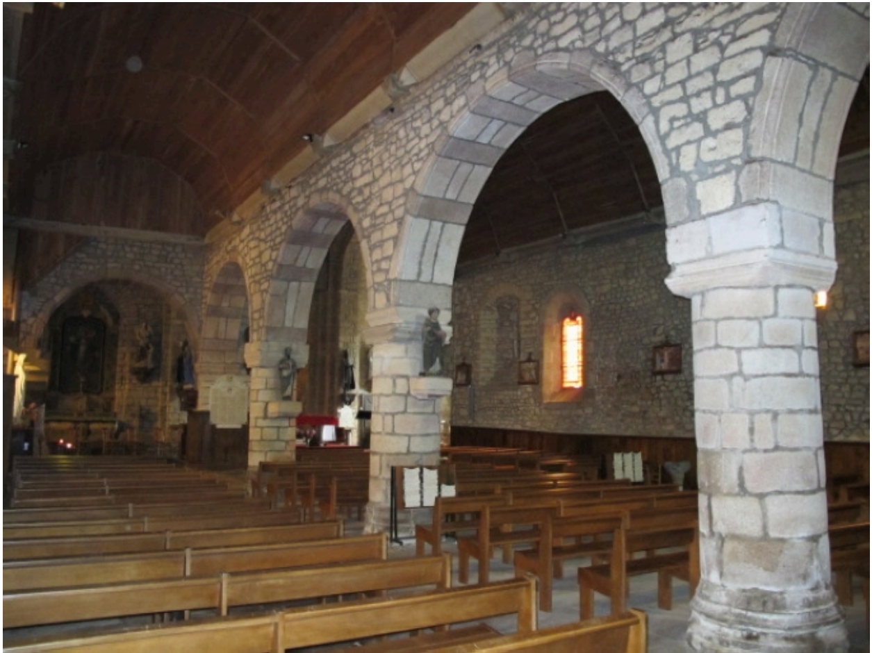
Vue générale intérieure
