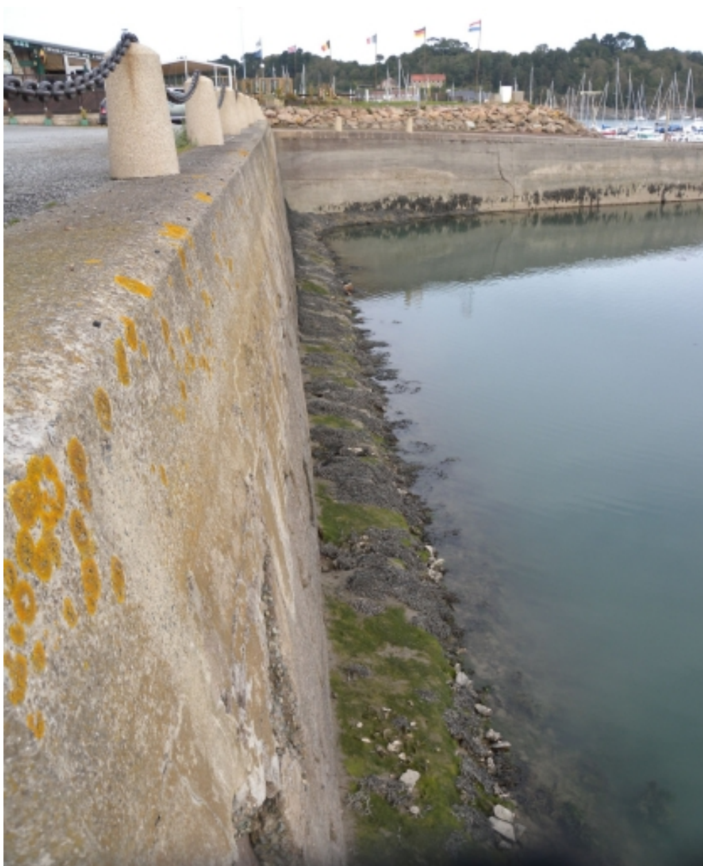
Vue des nouveaux ouvrages : quai et cale en béton
