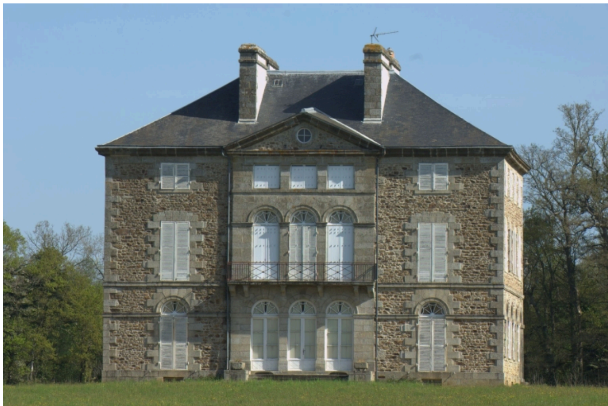
Château, vue rapprochée sud
