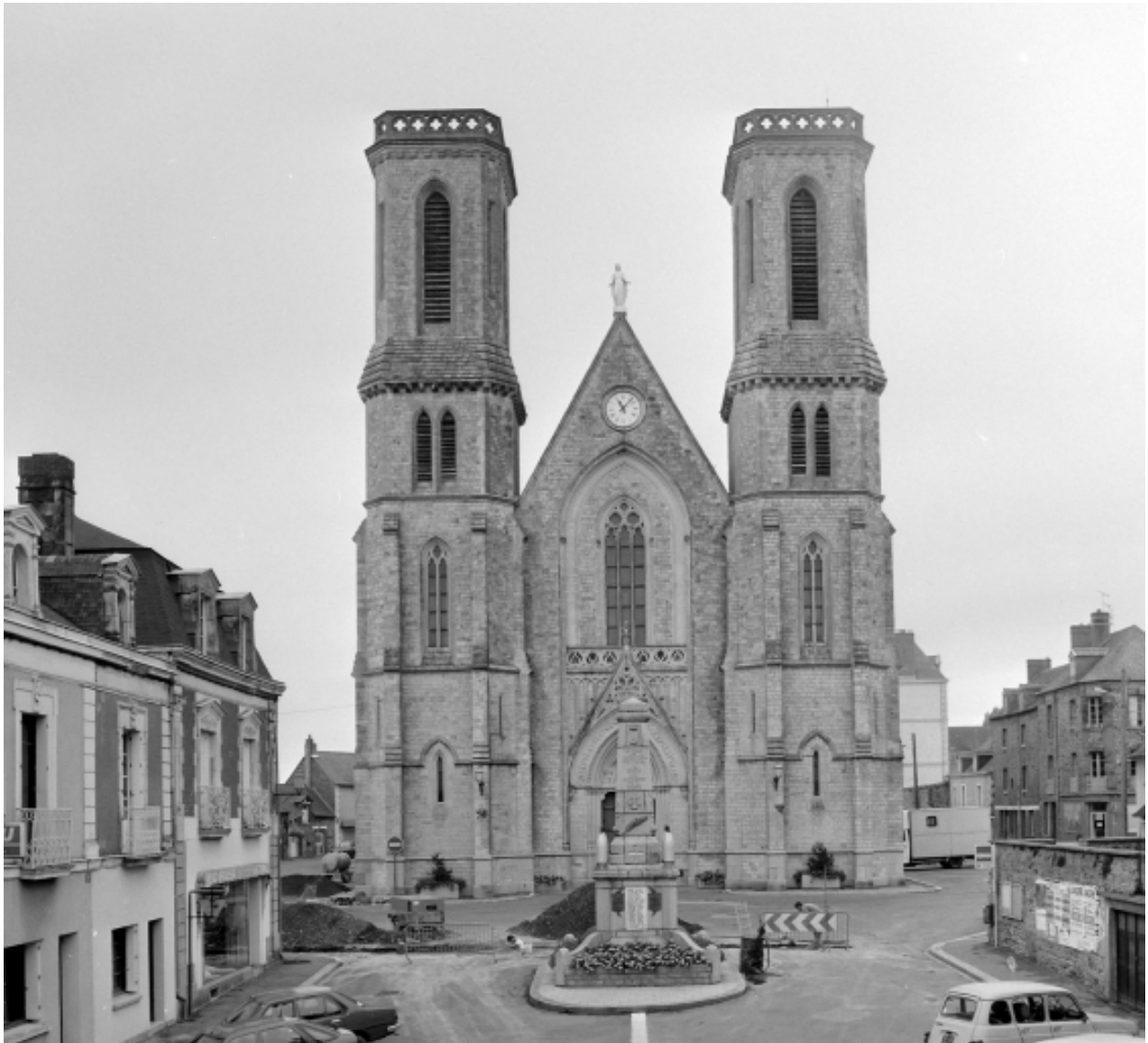
Elévation ouest : vue générale
