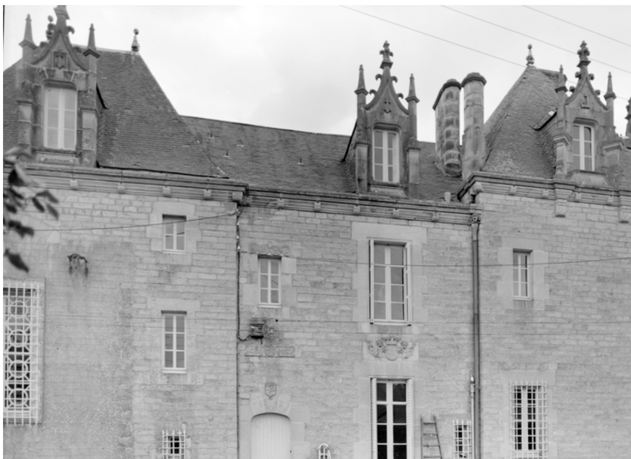
Elévation nord : vue de la partie est (état en 1984)
