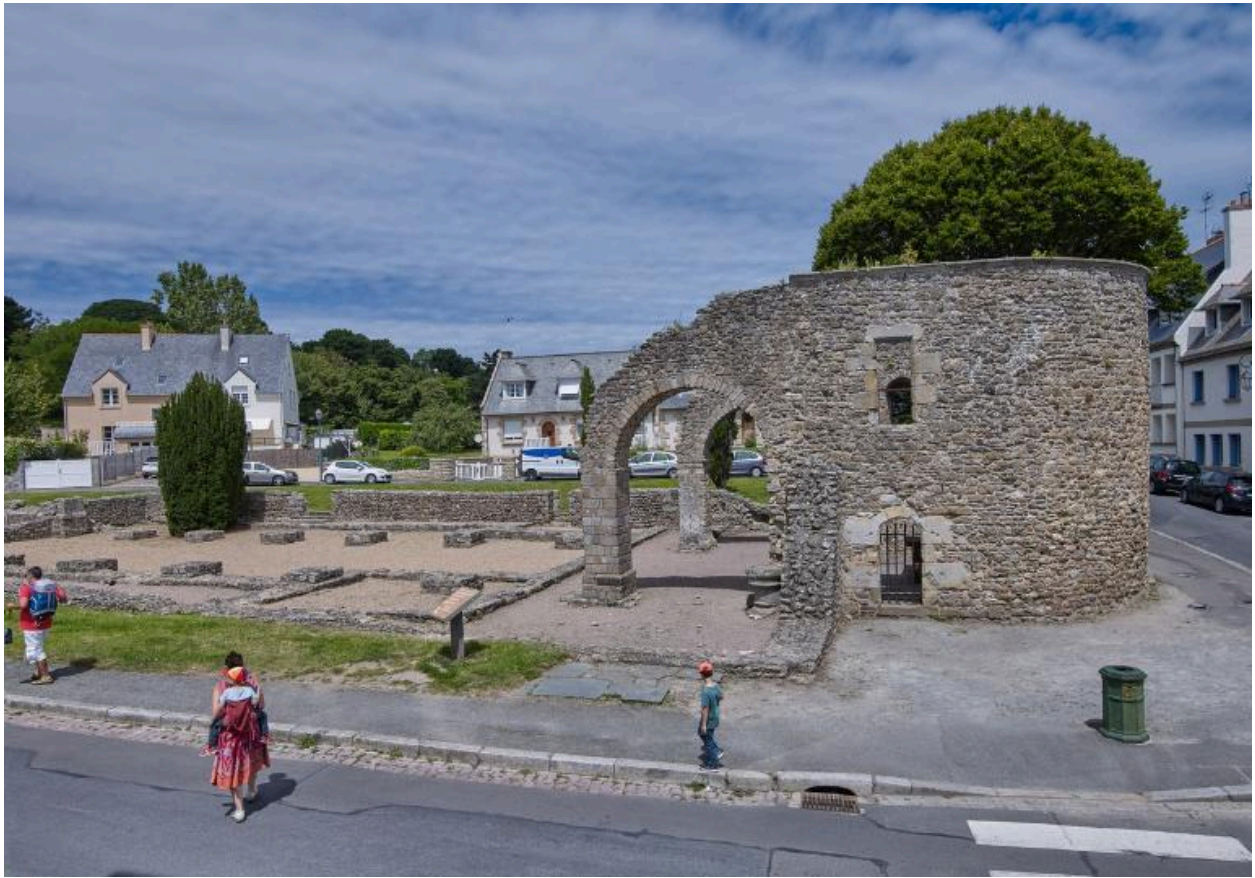
Abside orientale, vue générale depuis le sud
