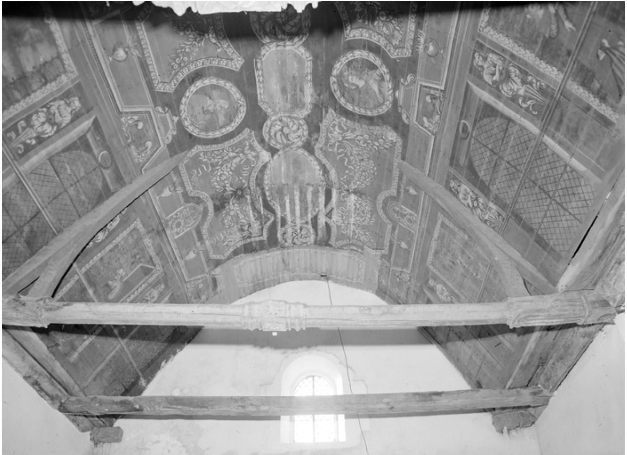
Voûte, détail de la partie ouest du lambris peint.
