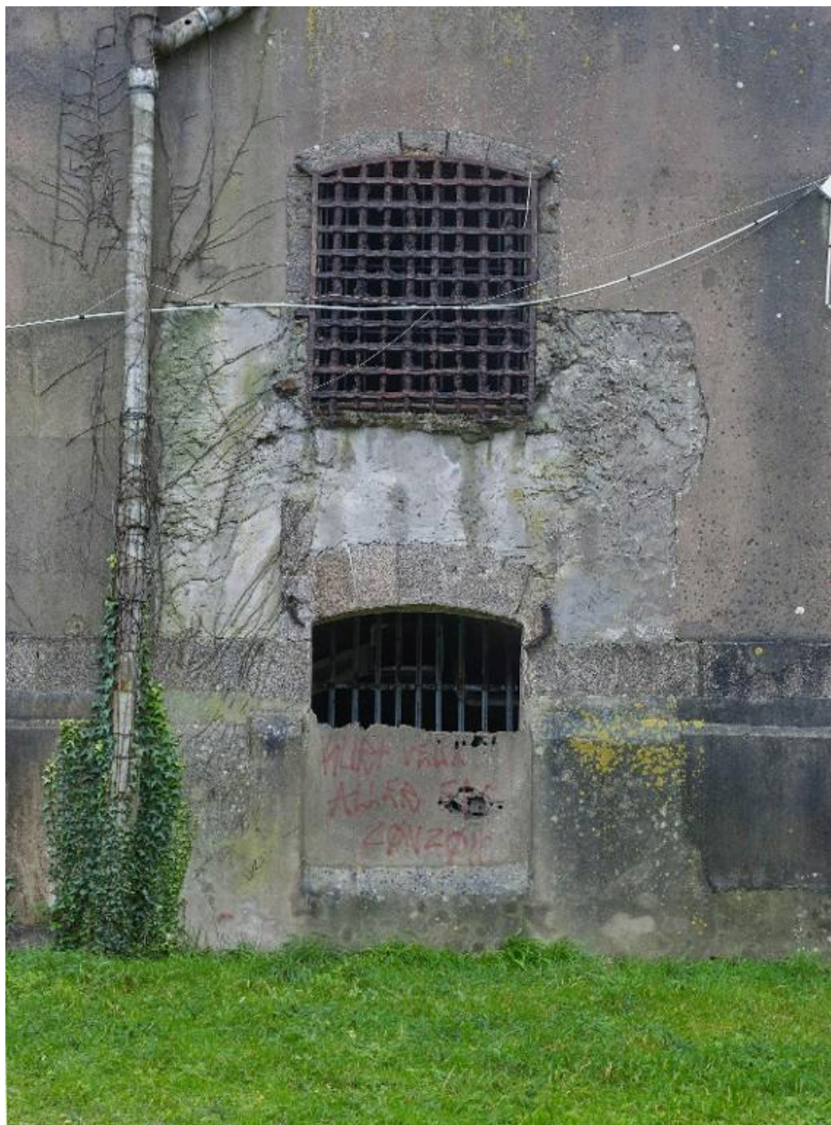
Vue de détail du pignon nord du bâtiment carcéral : porte partiellement murée (?) et fenêtre dotée d'une grille
