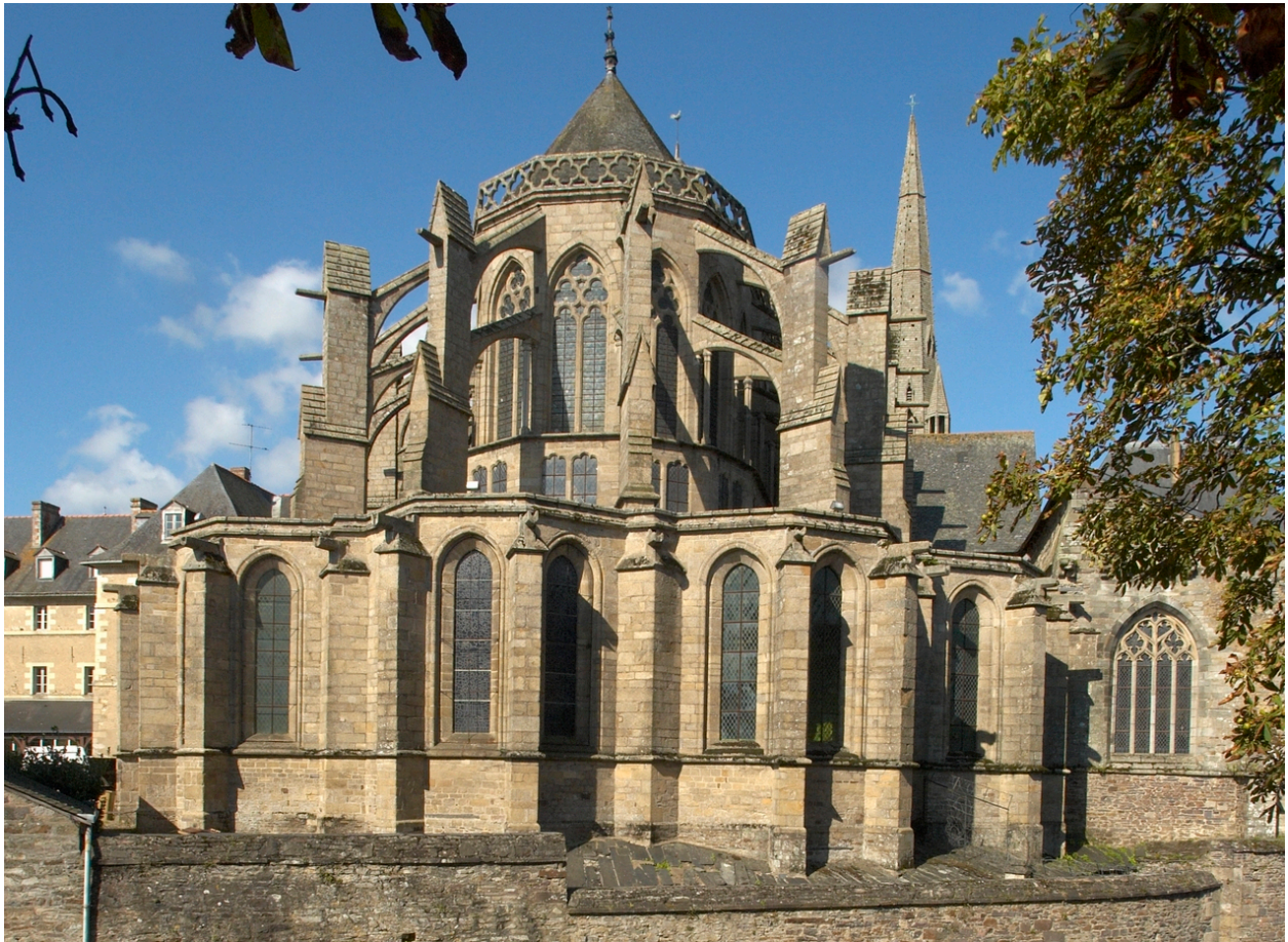
Redon. Ancienne abbatale Saint-Sauveur. Vue du chevet et de ses chapelles rayonnantes
