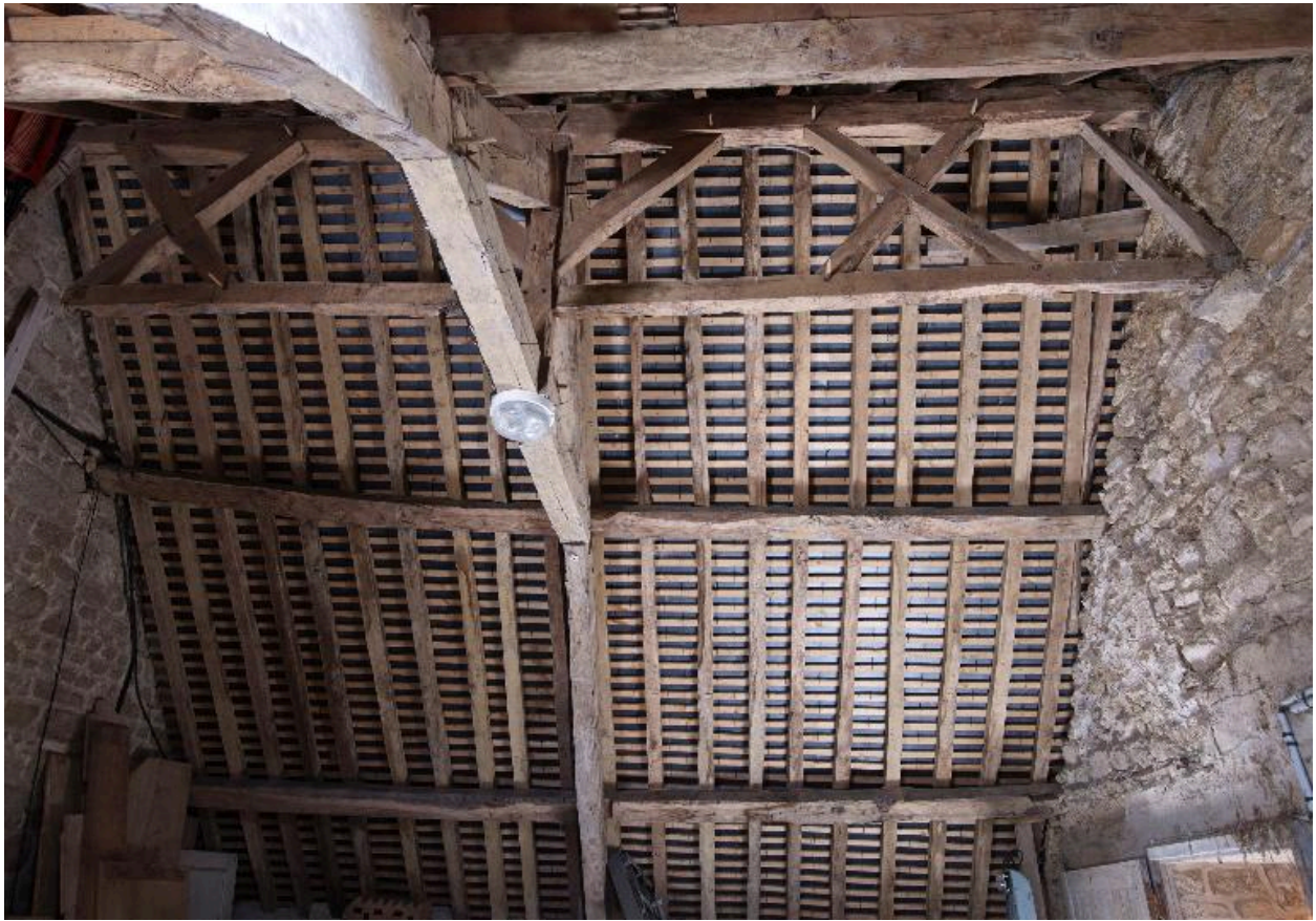
Vue de la charpente
