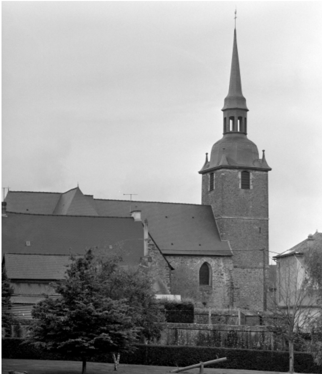
Elévation Nord, partie Ouest : vue générale
