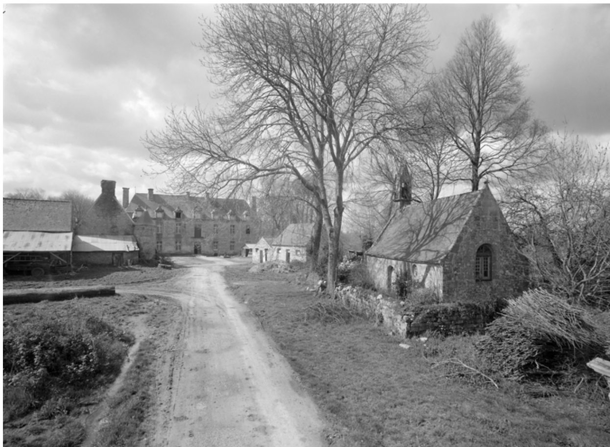
Vue de situation de la façade principale
