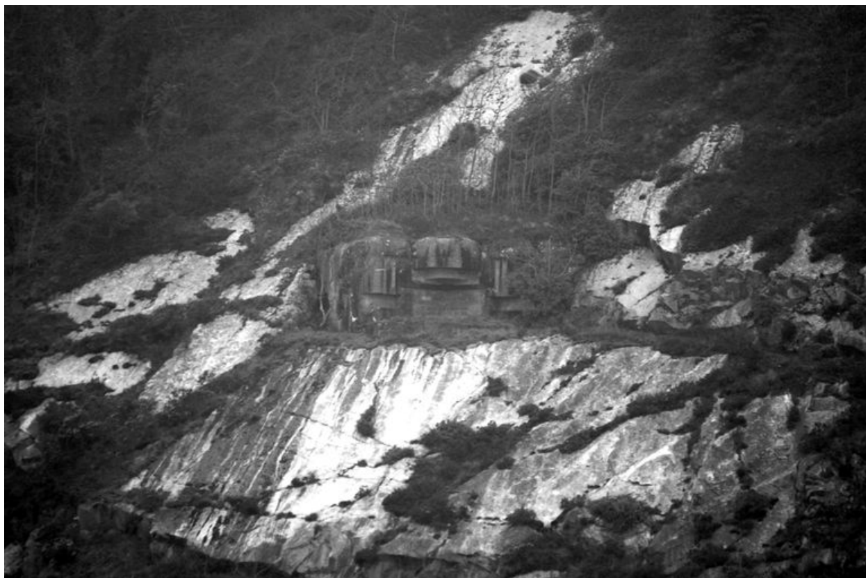
Casemate à flanc de falaise de la batterie d'artillerie du Fort du Roule
