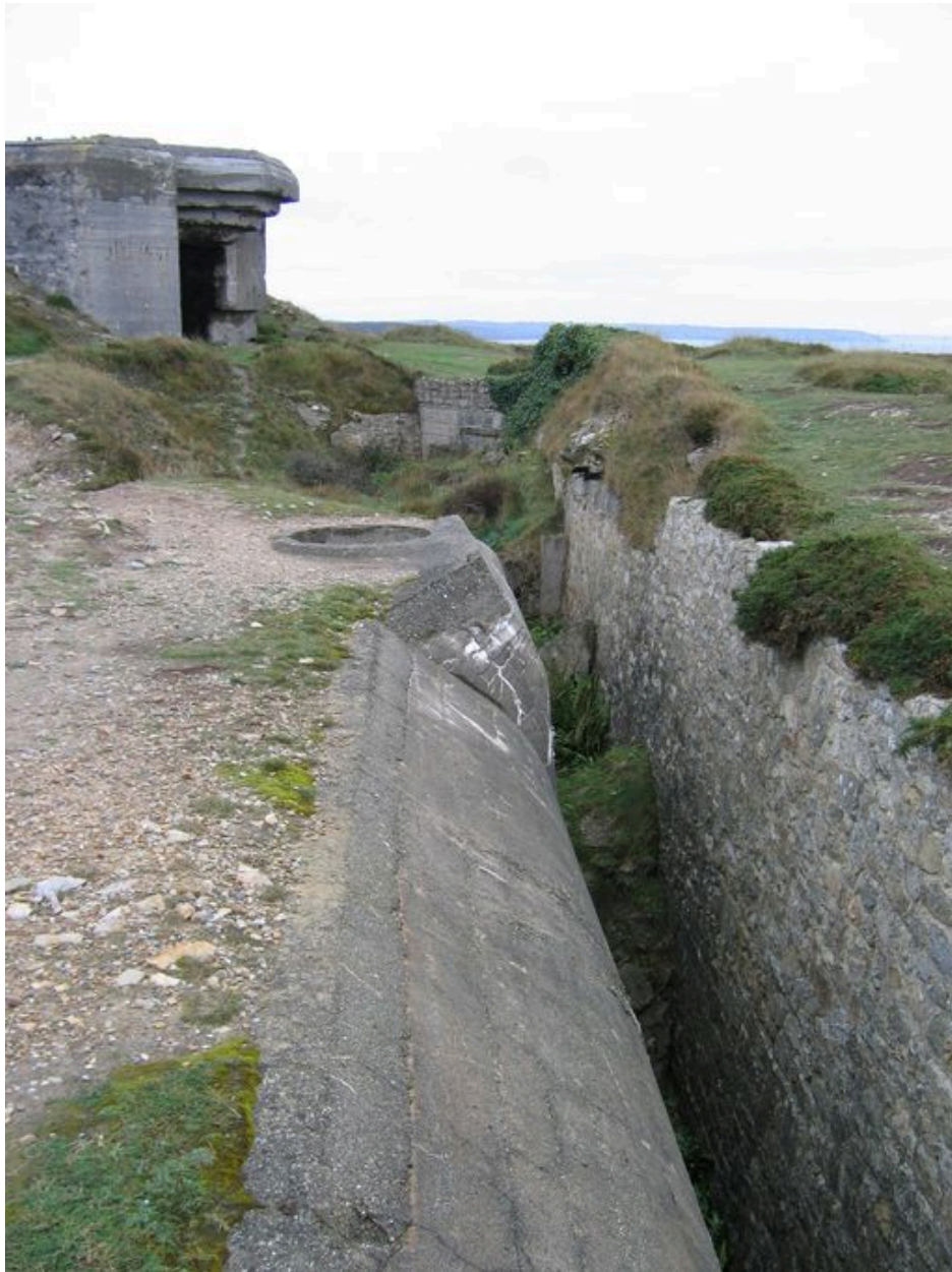
Vue d'une tranchée
