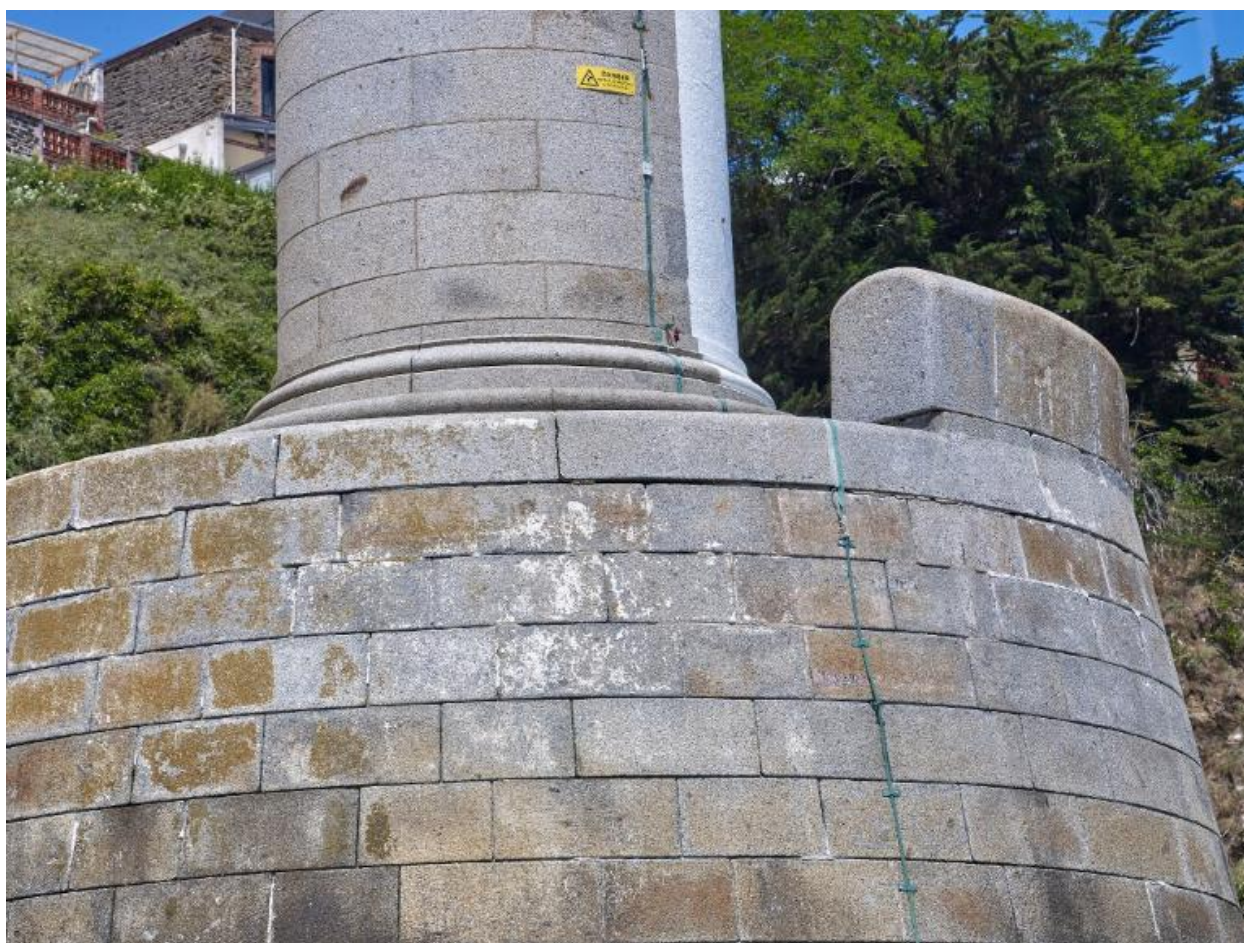
Maçonnerie du musoir de la jetée et du phare
