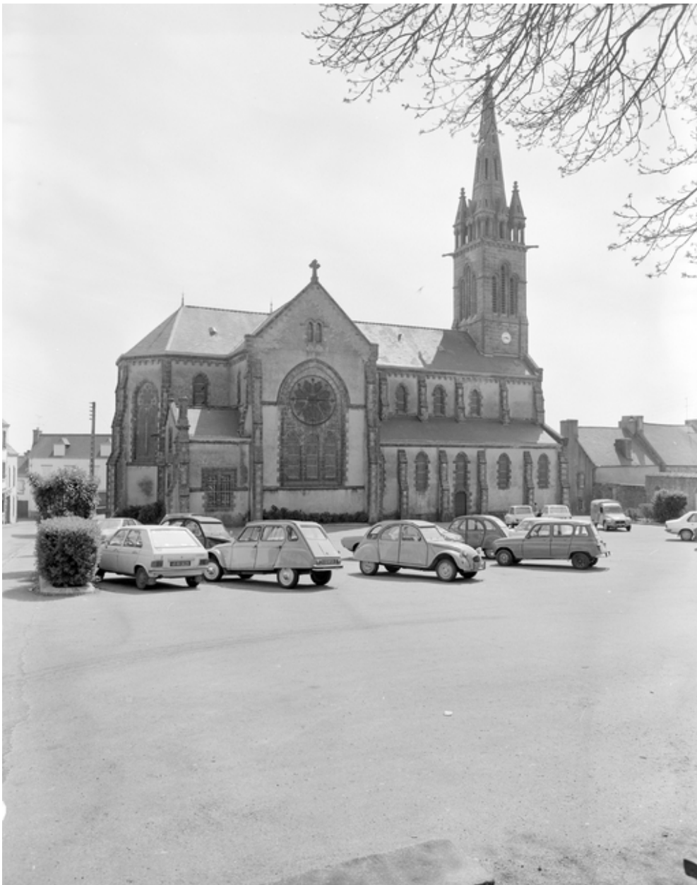
Plogastel-Saint-Germain, église paroissiale Saint-Pierre : élévation nord, vue générale, état en 1982
