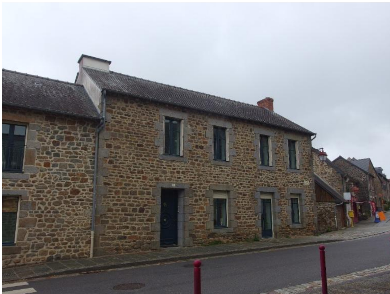
Vue de la façade est
