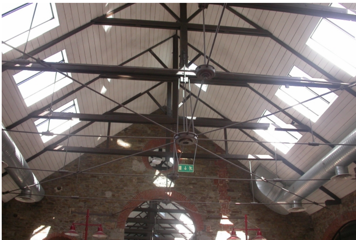
Détail de la charpente
