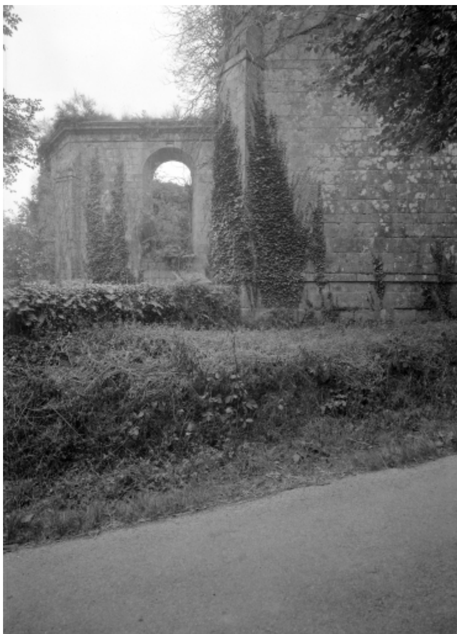
Chapelle, mur v du choeur
