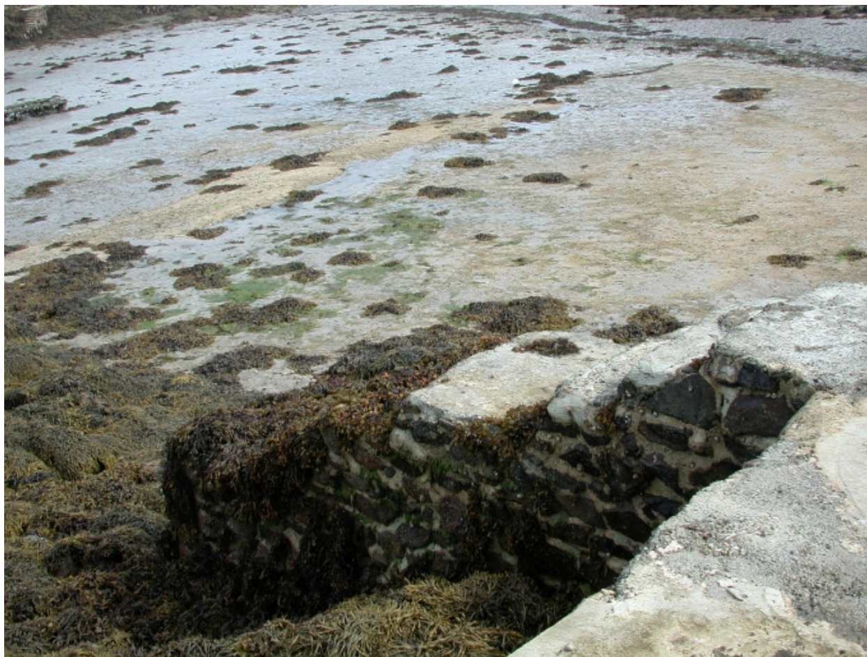
Vue des marches cimentées de l'escalier du quai Sud
