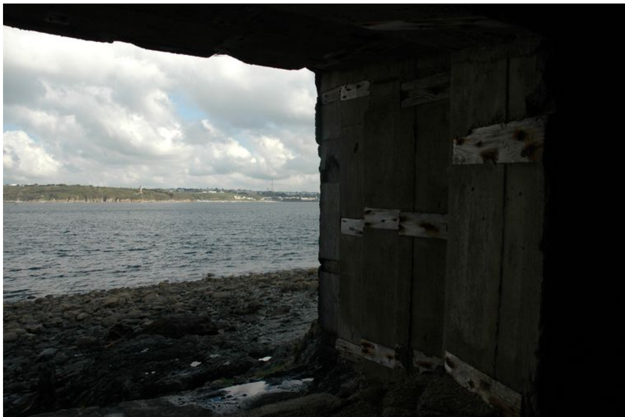
Vue du panorama depuis la batterie casematée (état en 2006)
